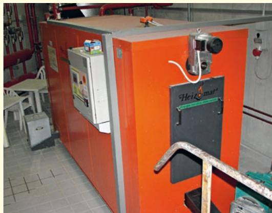
**Foto C** - La caldaia Heizomat HSK-RA 200 da 180 kW consuma circa 90 t per un totale di 200 MWh utili
